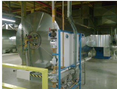
Incinérateurs de COV
